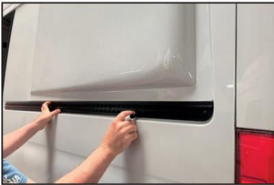
1. Schiene am Fahrzeug ausrichten.
